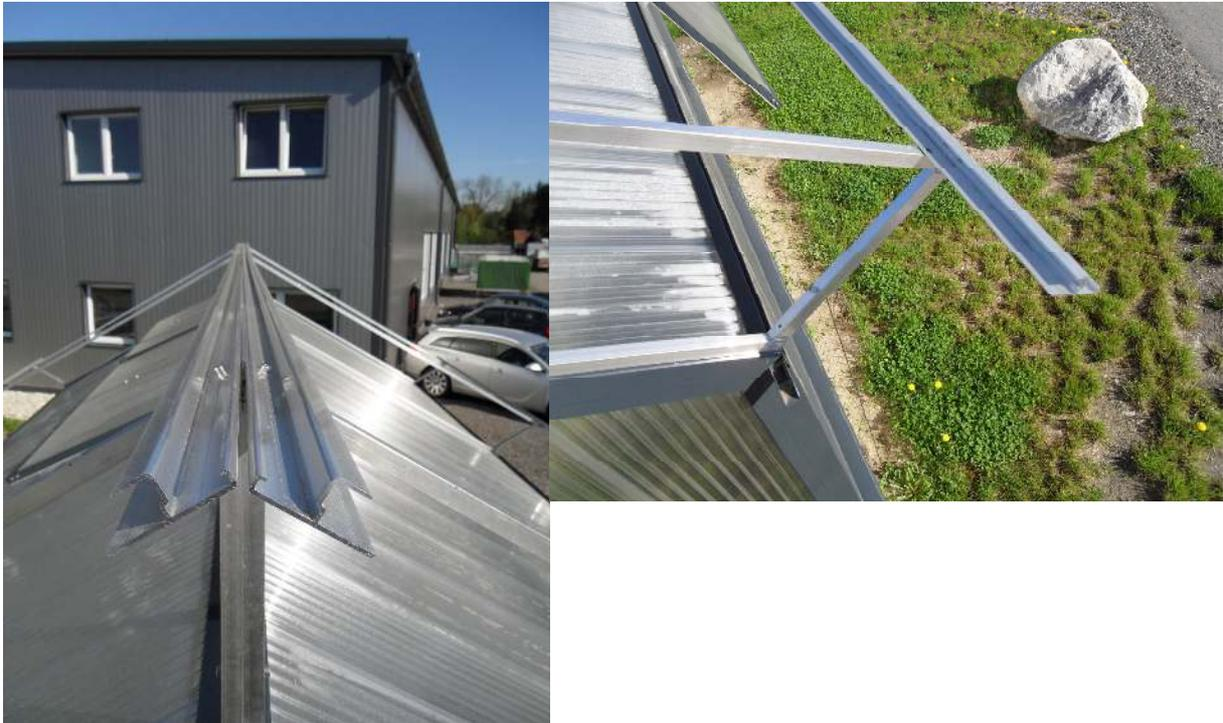
Anschrauben und Position der Längsprofile am Tragrahmen. Bei Häusern über 5 Metern Breite ist in der Mitte ein H-Profil angebracht, da die Rahmen mit den Netzen sonst zu lange werden würden.
