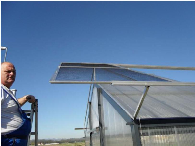
Dann schiebt man den ersten Rahmen ein: Achtung – die Verbindungslaschen und die Mittelabstrebung (Ab 3,5 Meter Hausbreite) sind Außen!!
