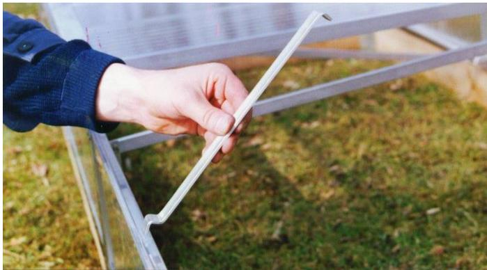
Der Lüftbügel wird – wie auf dem Foto gezeigt – in der Vorderwand in die Profilmutter gesteckt.
