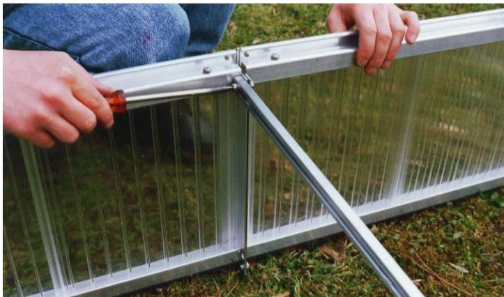
Die Verlängerungsteile werden oben mit der Querstrebe (siehe Foto) mit Schraube M6x 20 mm verschraubt.
