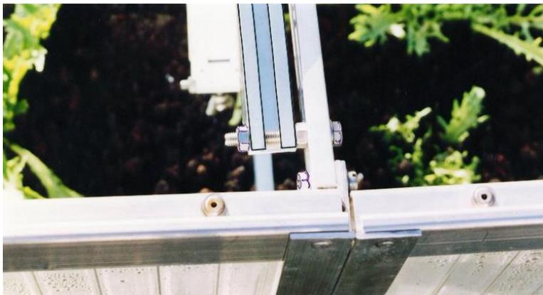
Der „LÜFTCHECK“ und „LÜFTCHECK“-Arm sind so richtig montiert, müssen sich jedoch auf den Schrauben drehen.
