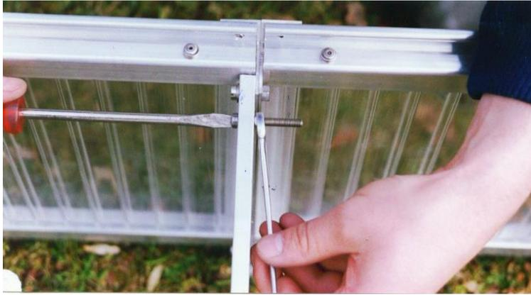
In der oberen Querstrebe befestigen Sie die mitgelieferte lange Schraube. In der Schrägstrebe ist diese Schraube von uns bereits eingesetzt. (Siehe auch vorheriges Foto, die mit Kreis gekennzeichneten Schrauben.)
