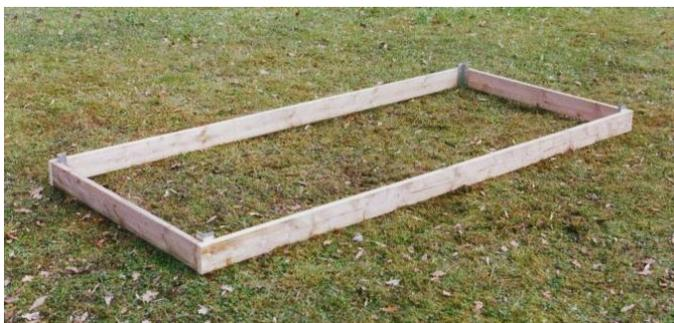
Damit die Fenster eines Frühbeetes optimal im Rahmen der Seiten-, Stirn- und Rückenwand aufliegen, sollte die gesamte Konstruktion immer mit der Wasserwaage ausgerichtet werden. Um dies optimal zu gewährleisten, ist ein Hilfsrahmen aus Holz, auf dem Sie das Frühbeet schrauben, von Vorteil.
