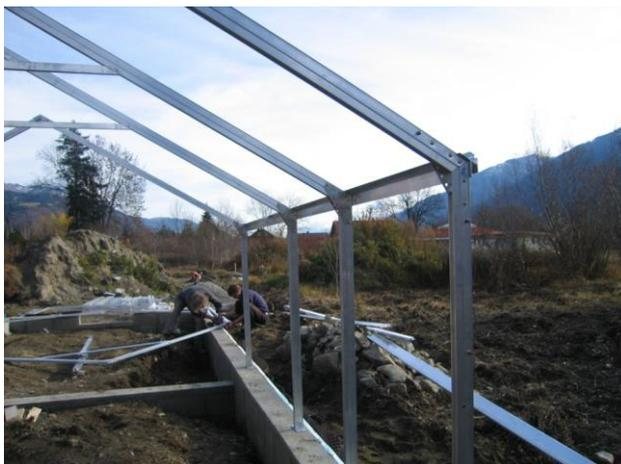
Gerüst mit Dach-Hauptprofil NR5 an Traufe
