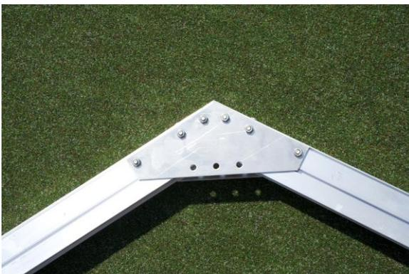
Träger mit Trägerspannplatten, verschraubt
