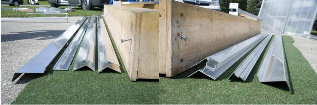
Es empfiehlt sich, diese Profil gleich richtig entsprechend der späteren Position der Lüftungsöffnungen aufzulegen
