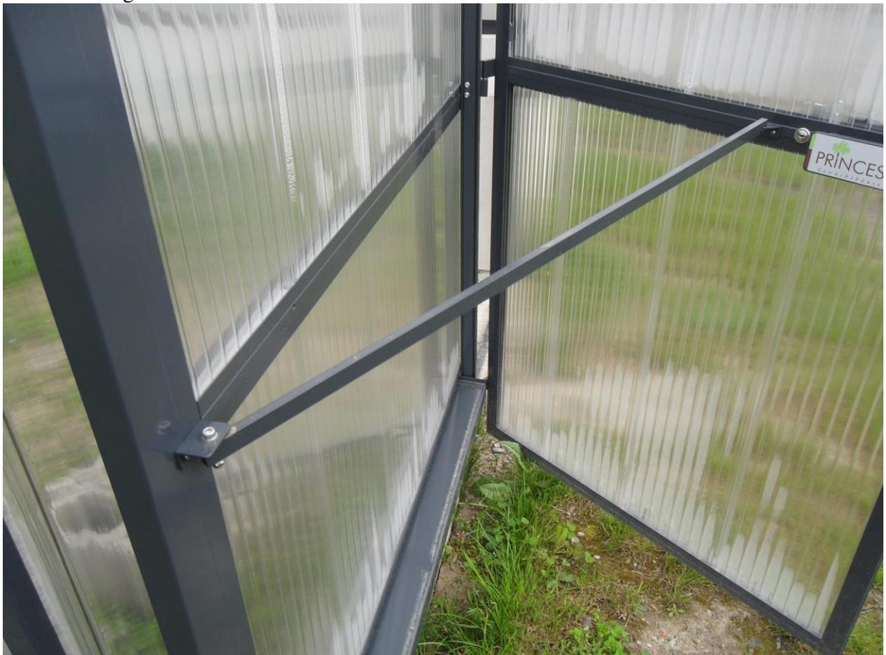
Je nach Haus- und Fundament wird die Türarretierung entweder am H-Profil, am Wetterschenkel oder an der Blende angeietet. Das Gegenstück – die Öse in entsprechender Höhe am Rahmen der Tür
