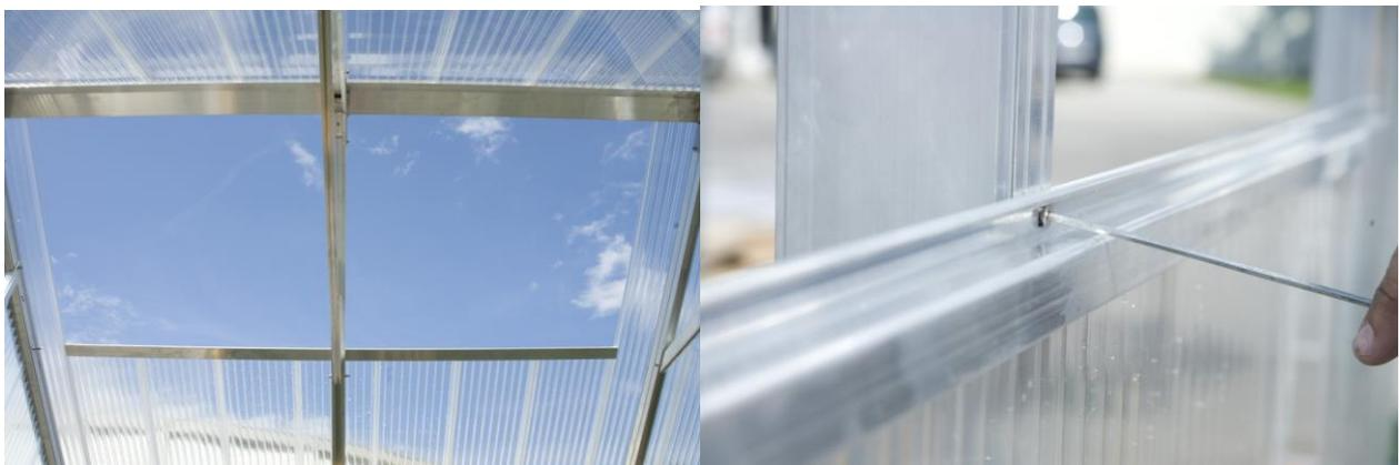
Frühbeetprofil zum Einfassen der Fensteröffnung in der Dach/Seitenwandverglasung
