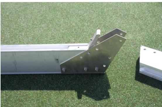
Bei Gewächshäusern mit Trägerprofil „M“ (NR 2) über 6 Meter Länge findet sich bei den Trägern ein „Stückelungsträger (NICHT bei Träger „S“!!)
