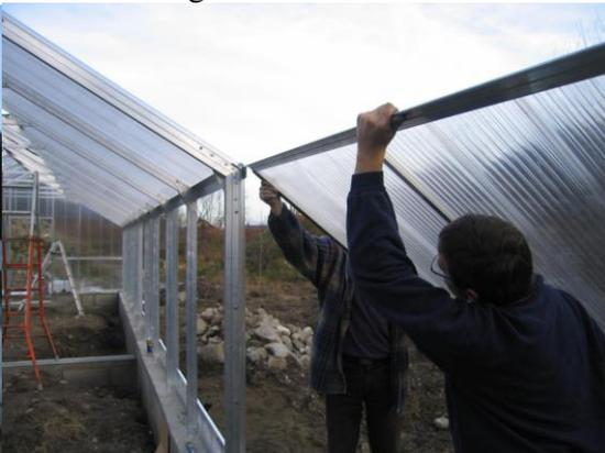
Montage Klappenelemente – einschieben, einfetten nicht vergessen
