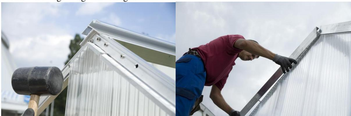
Firstglas in Rück/Vorderwand (Breite 125mm) Montage Dachblende
