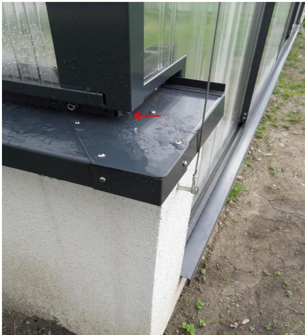
**Wetterschenkel – Abdeckung**, Mit Silikon aufkleben und mithilfe der beigelegten Metallschrauben (Vorbohren 3mm) anschrauben – oder wenn vorhanden annieten. Abdichten der senkrechten kante der Frühbeetprofile nicht vergessen (Pfeil)
