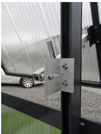
Montagekonsole Handgestänge an Steher – Im Langloch können sie die Vorspannung abhängig vom Steher einstellen.
