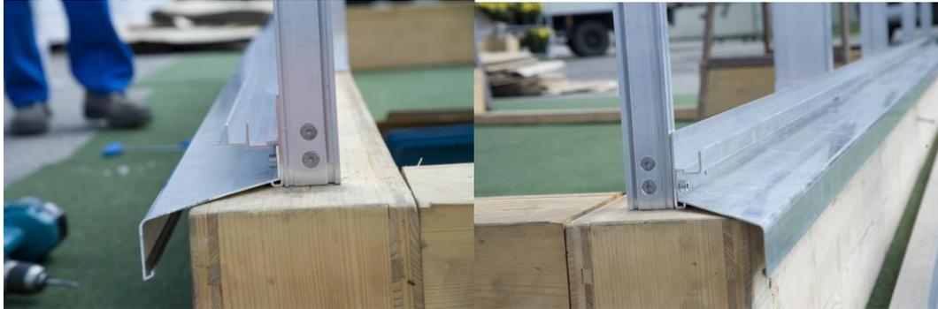
Bei Häusern über 4 Meter Breite ist speziell jene Dachseite parallel zum Firstprofil, an der sich keine Dachkippflügel angebracht sind ein Verbindungsanschlussprofil (NR18 in Kombination mit Z-Profil NR 19) angebracht, das die Dachverglasung aus Stabilitätsgründen auf 2 separate Reihen unterteilt.
