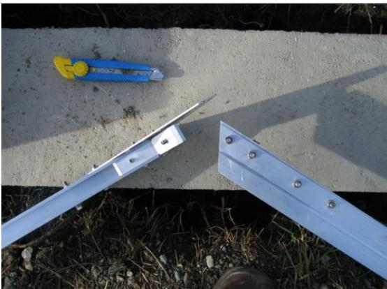
Vorder- oder Rückwandsteher mit nur einer Trägerspannplatte und Verstärkungsprofil
